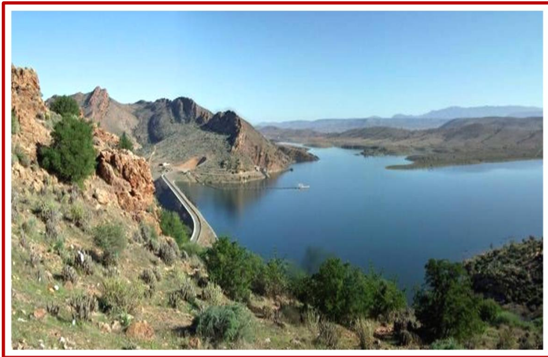
Barrage Youssef IBN TACHFINE
